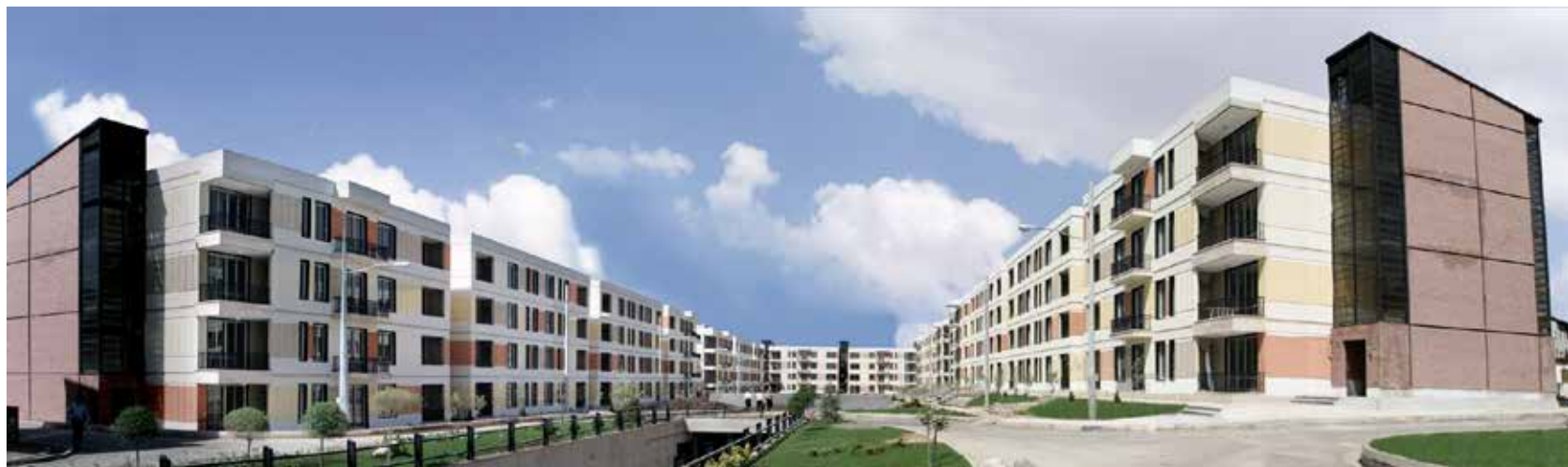
۵۵۲ واحد مسکونی شهر جدید پرد
