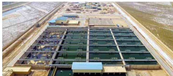
تصفیه‌خانه فاضلاب شرق اهواز
