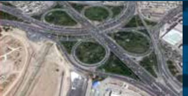
تقاطع غیر همسطح افسریه
